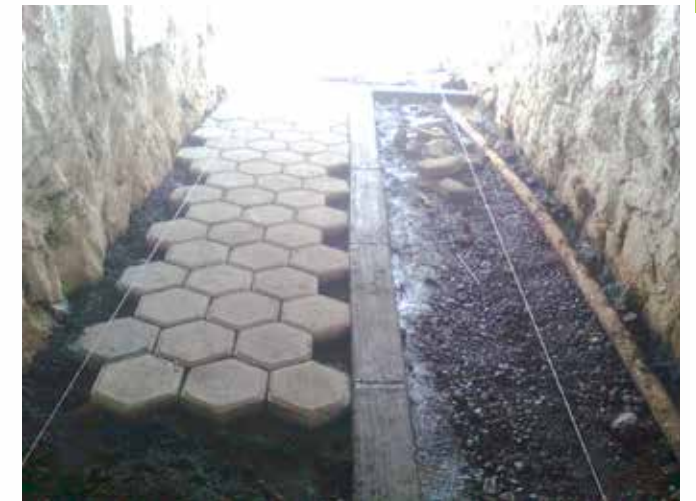
Trabajos para la rehabilitación del paso peatonal de la calle Juárez
