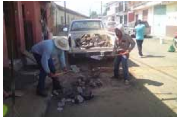
Realización y supervisión de obras
