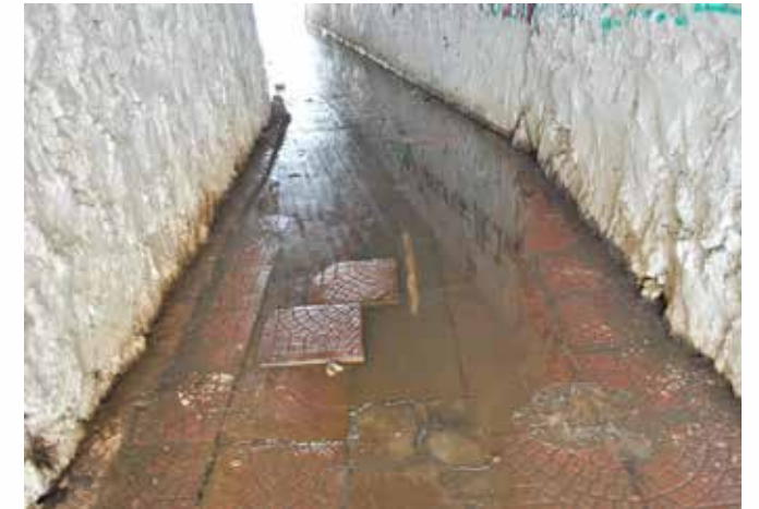
Trabajos para la rehabilitación del paso peatonal de la calle Juárez
