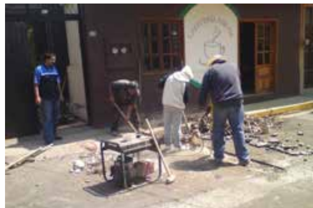
Realización y supervisión de obras
