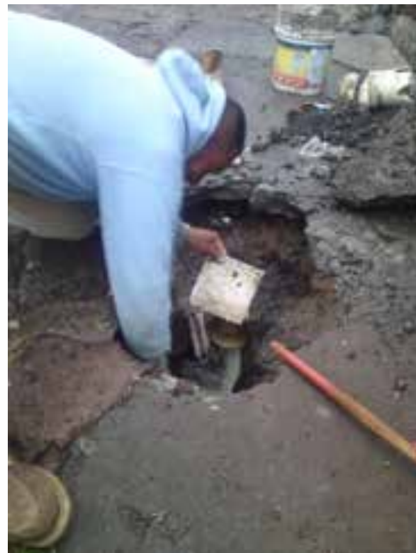
Realización y supervisión de obras
