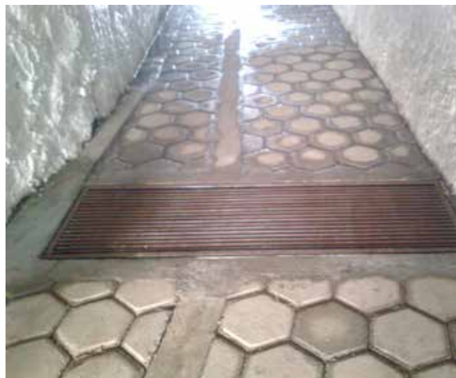
Obra terminada del paso peatonal de la calle Benito Juárez
