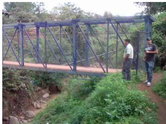
Inspección ocular a solicitud de los habitantes de la comunidad de patamban para el seguro y libre tránsito en el puente ubicado en una de las barrancas.
